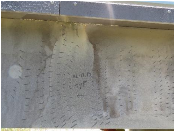
On girder G3
